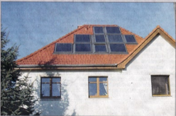
Beim Velux-Solarsystem sind die Dachfenster integriert.
